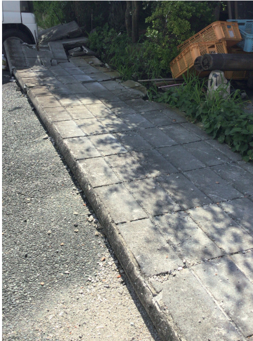
地震によりブロック塀が倒壊
