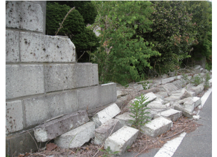
地震により石塀が倒壊
