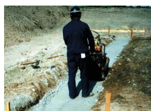
③ 基礎工事
