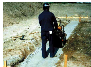
③ 基礎工事
