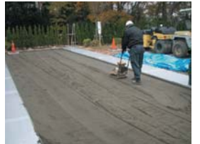
②レベル調整(転圧) レベル調整材(山砂、真砂土、スクリーニングス)を投入敷きならし。プレートで転圧。厚み5~10mmに仕上げます。(ローンベースの高さはGLに合わせます)
