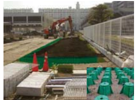
④客土投入 敷設後黒土を投入し敷きならします。竹ぼうきで少し強めにすきとり、芝生の厚みを考慮してローンベースの先端部が20mm程度露出するようにします。
