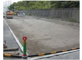
①路盤整地 200~300mm下掘りし、整地後クラッシュラン(砕石材)0~40を投入。十分に転圧(2~4t)整地します。
