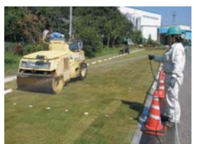
⑥散水・転圧・目砂 散水しながら2~4tの転圧をかけ、化学肥料等を散布し、最後に芝の目砂をし、芝生が根付くまで養生をしてください。
