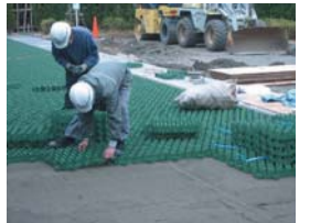
③ローンベース設置 ローンベースのタテ、ヨコの1コーナーを決め、接合部分は凸部の上に凹部を重ねて上から押し込むようにして組立てます。一列ごとに前後左右を確認して、ゆがみの無いように調整してください。曲面、角部分は剪定ばさみ等で、本体がはみだした部分をカットします。
