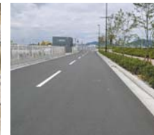
車道アスファルト
