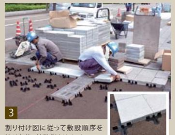
3 割り付け図に従って敷設順序を決めた後、基準側よりインターロッキングブロックと強化板を敷設する。その後、目地砂をブロック敷設面に散布し、ブロックコンパクターで締め固めを行い、さらに目地が一杯になるまで目地砂を充填する。
