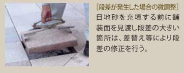
【段差が発生した場合の微調整】目地砂を充填する前に舗装面を見渡し段差の大きい箇所は、差替え等により段差の修正を行う。
