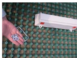
①ローンストッパー1本にコの字ピン2本とナット・ワッシャー4個を使用
