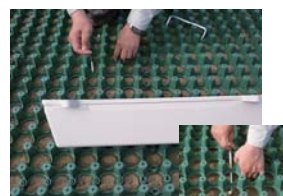
④ローンベースを持ち上げて位置決め1・2で決めた位置に、コの字ピンをくぐらせる
