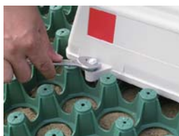
⑨4カ所を17mmスパナー等で本締め ※コの字ピンの先端(ネジ山)が5~10mm出る程度で止め完成。 ※締めすぎないようにする。
