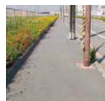
歩道アスファルト
