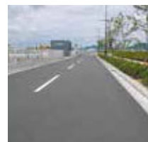
車道アスファルト
